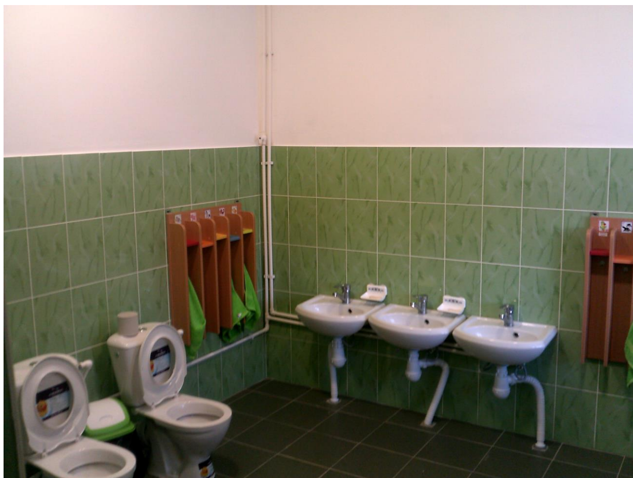
Фото №5. Санитарно-гигиенические помещения.
