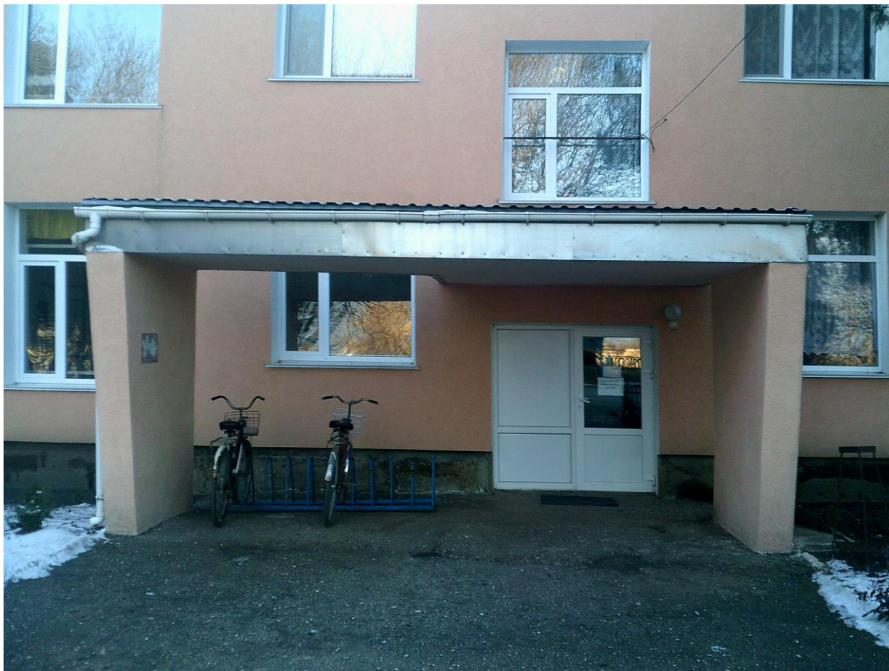
Фото №2. Вход (выход) в здание.
