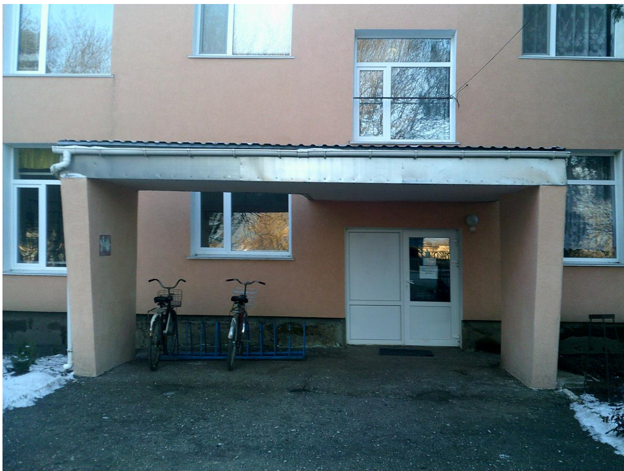
Фото №2. Вход (выход) в здание.
